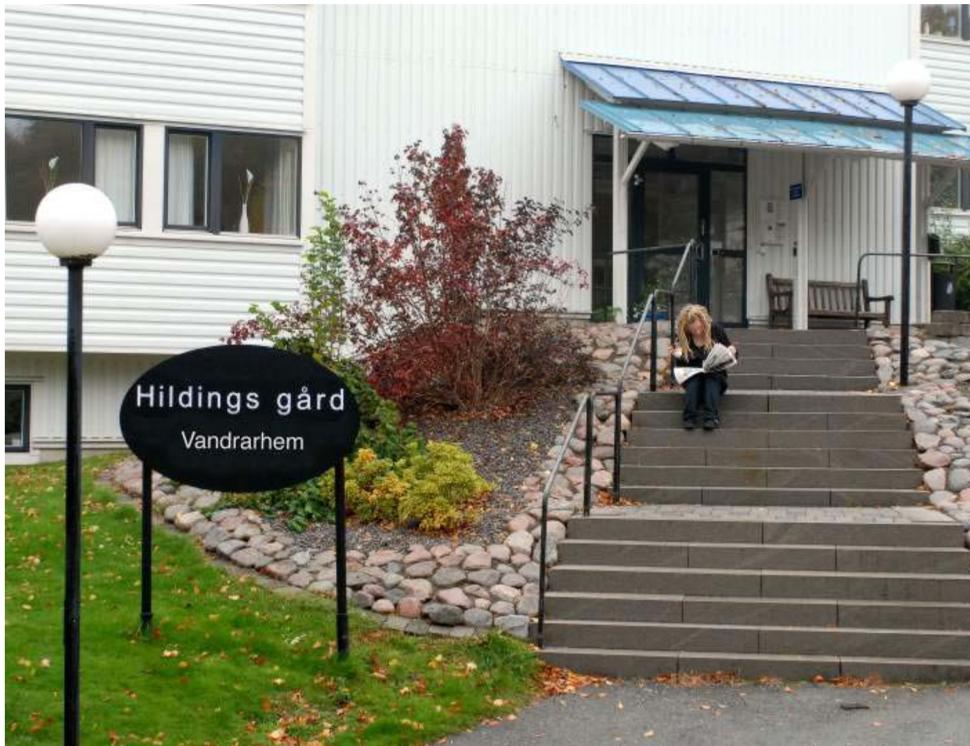
Hildingsgård. En av våra byggnader där du bor i våra vandrarhemsrum.
